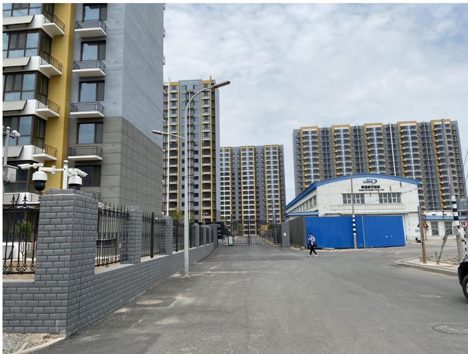
职工住宅楼现状
