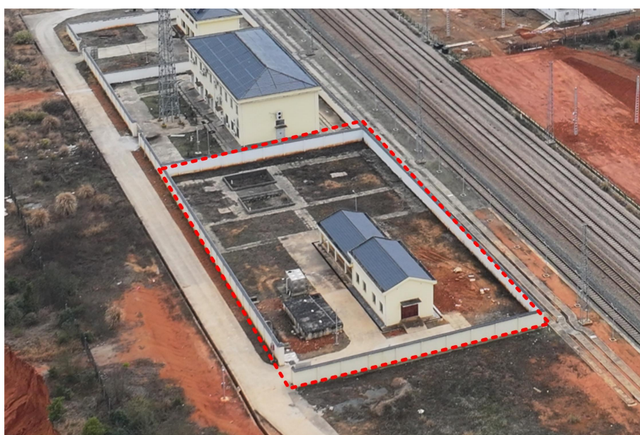
图 2.3-6 上高站污水处理站
