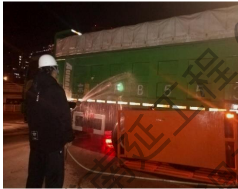
图 6.2-2 现场检查渣土车清洗情况
